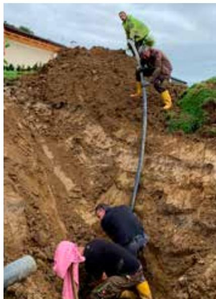
Reparatur der Wasserleitung in Gigging nach Hangrutschung.
