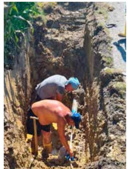
Reparatur der Wasserleitung nach einer Straßensetzung in Dollrath.
