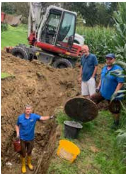
Reparatur der Kanalleitungen nach Hangrutschung in Höllgrund.
